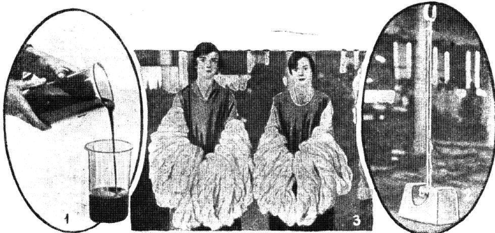
1. Добытая из дерева и похожая на патоку вискоза, из которой вытянутся шелковые нити. 2. Испытание крепости искусственной шелковой нитки. 3. Мотки искусственных шелковых нитей, готовые для выделки чулок и тканей.
